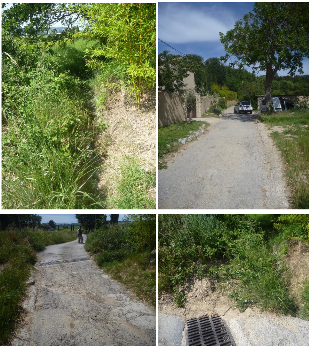
Figure 30 : Vues des environs sur le chemin sous Cabasse à son intersection avec le chemin de Sous la Garde
