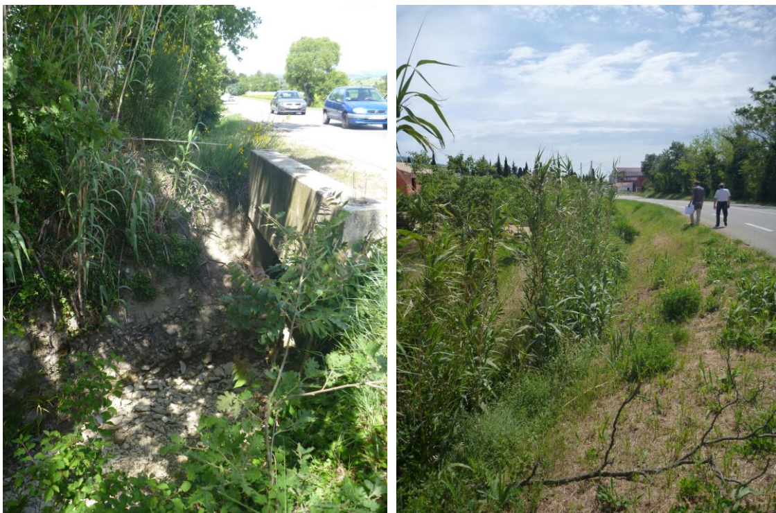
Figure 12 : Vues des environs en tête du réseau au nord de la RD977
